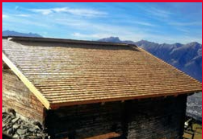
Das neugedeckte Schindeldach
